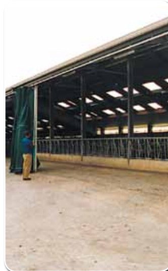
In geöffnetem Zustand benötigt ein Vorhang nur wenig Platz
