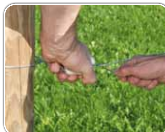
7. Loses Drahtende 5-mal um den Zaundraht wickeln
