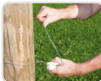
3. Loses Drahtende durch den Zugisolator hindurchführen
