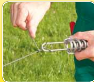
Die überstehenden Drahtenden um den Zaundraht wickeln
