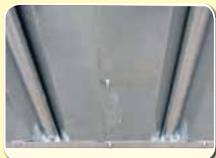
Doppelte Verstärkungsrohre unter dem Bodenblech
