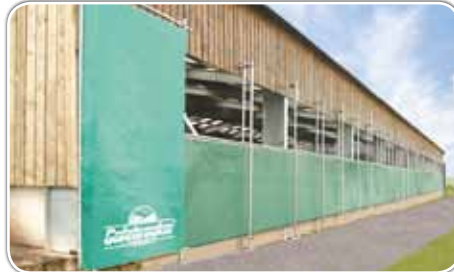
Variable Seitenlüftung - teilweise offen für optimale Anpassung der Lüftungsverhältnisse
