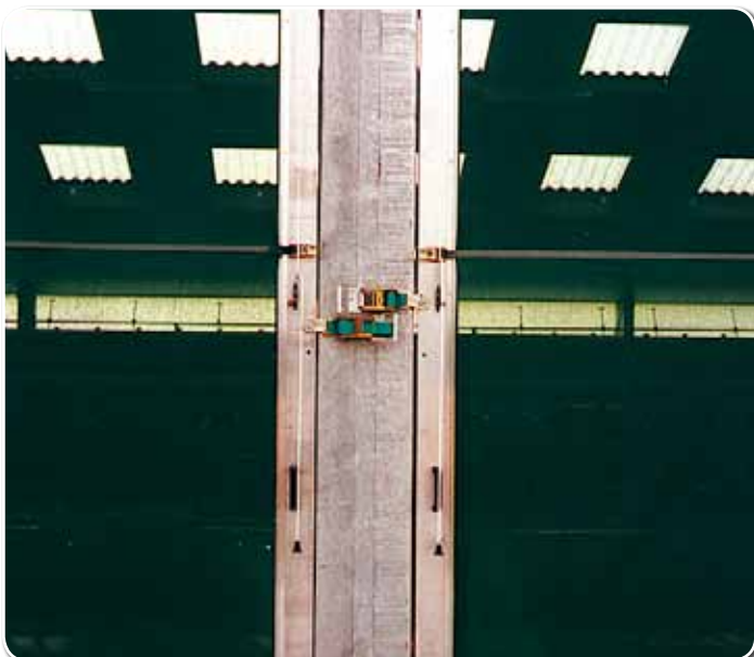
Ratschen sorgen auch bei starkem Wind für feste Spannung
