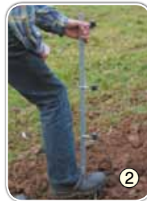
Eckpfähle an allen Ecken und Kurven setzen
