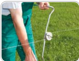
Spannbügel solange drehen bis die richtige Zaunspannung erreicht ist.
