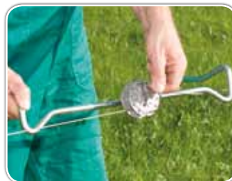
Spannbügel in den Draht einhängen, Sicherungsbügel einsetzen und Spannbügel entnehmen
