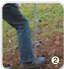
2 Eckpfähle an allen Ecken und Kurven setzen
