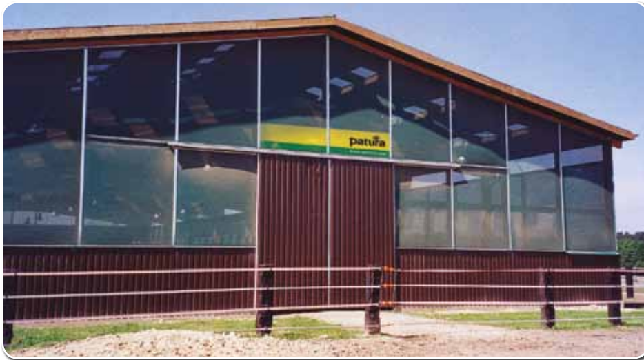
Fest installierte Windschutznetze bieten helle Gebäude, preiswerte Baulösungen und attraktive Gebäudefassaden
