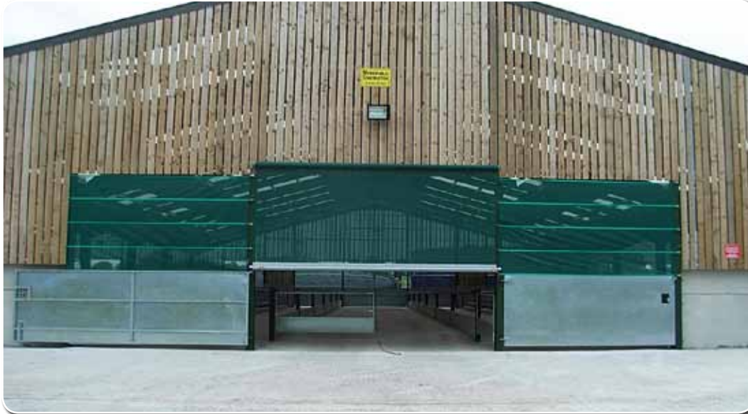
Abschluß einer kompletten Stallseite mit der Möglichkeit für ein schnelles Öffnen
