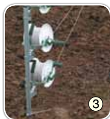
3 Litzen an den Haspeln fassen und abrollen
