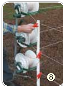
Anbringen der Quer- verbindungen ca. alle 200 m
