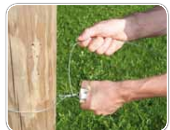
4. Ende 5-mal um den Zugdraht wickeln
