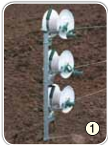
Montagepfahl mit Haspeln in einer Ecke platzieren
