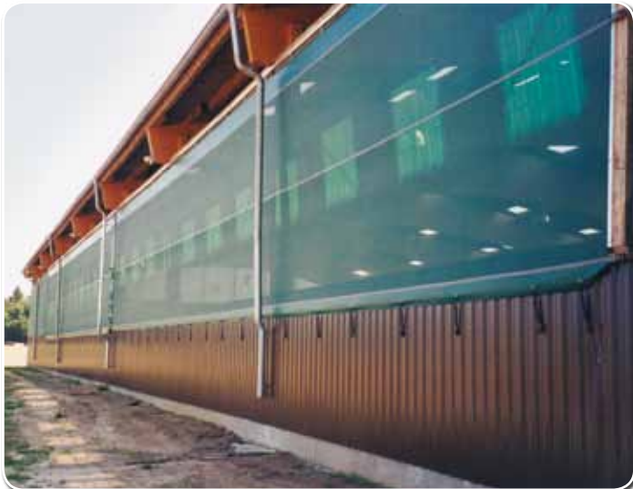
Windschutz-Vorhangssysteme für optimale Licht- und Klimaverhältnisse; die gesamte Reithallenfront lässt sich leicht zur Seite schieben
