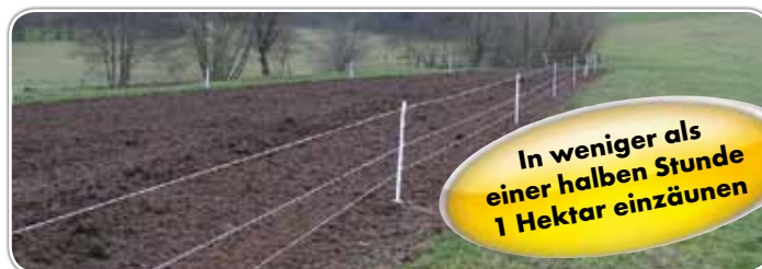
7 Setzen der Kunststoffpfähle und Einhängen der Litze
