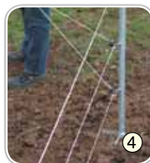
4 Litzen an den Ecken in die Eckrollen einhängen
