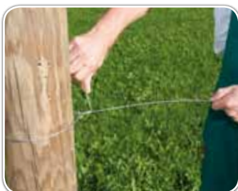
2. Loses Drahtende 3-mal um den Zugdraht wickeln
