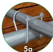
Kreuzklemmschraube Nackenrohr
