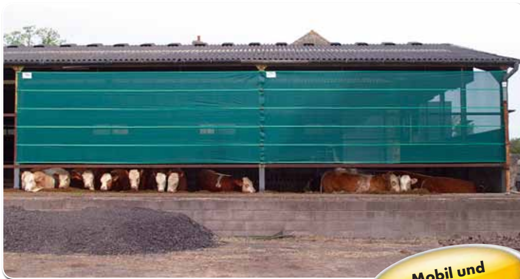
Artgerechte Rinderhaltung im Offenstall mit Windschutz-Spannpaneele
