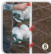
8 Anbringen der Querverbindungen ca. alle 200 m
