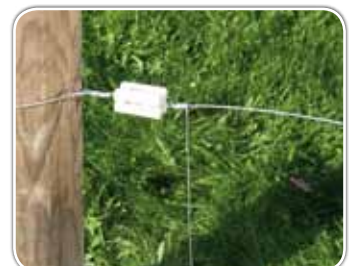
8. Drahtende lang lassen zur Querverbindung
