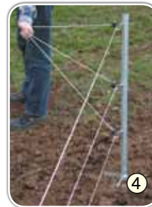
Litzen an den Ecken in die Eckrollen einhängen
