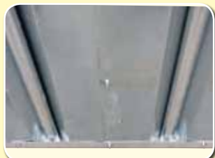
Doppelte Verstärkungsrohre unter dem Bodenblech
